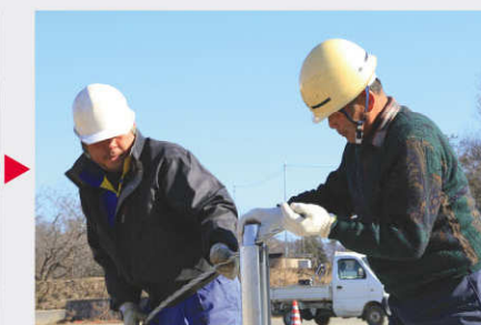
3 端末支柱用間隔材にワイヤーロープを通し、端末支柱の溝にストラップと共にセットします。
