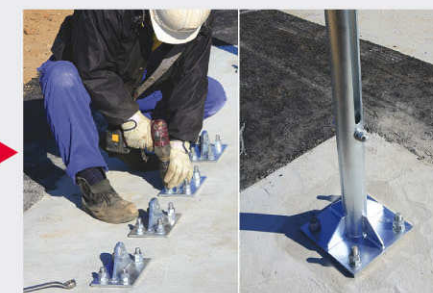
2 端末支柱、端末金具をアンカーボルトにより固定します。
