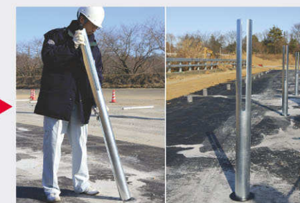
5 スリーブに中間支柱を挿入し、スリーブカバーをセットします。
