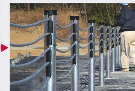
6 ワイヤーロープ、間隔材、ストラップをセットし、キャップを取り付けます。
