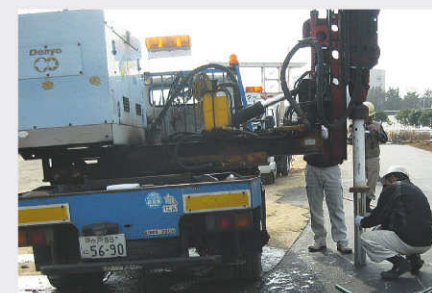
1 アスファルトをコア抜きし、エアーストライカーによりスリーブを打込みます。
