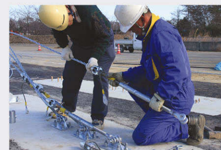
4 索端金具、ターンバックルを取り付け、ジョーボルトで端末金具に固定します。
