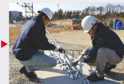
9 ターンバックルにより張力の調整を行い終了です。
