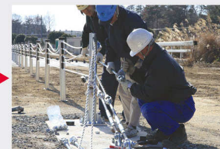
8 余分なワイヤーロープをカットし、索端金具を装着、端末金具に固定します。
